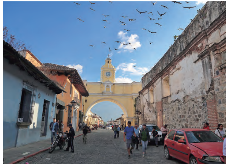
Emblemático arco de Santa Catalina, construido a finales del siglo XVII.
